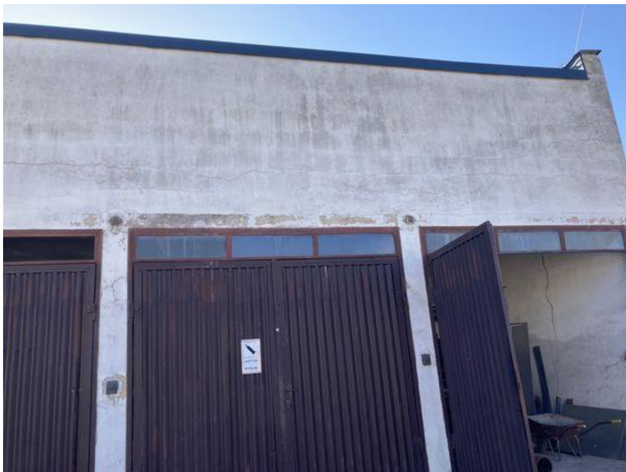
Obr.1. Trhliny ve stěně vjezdů do garáží.
