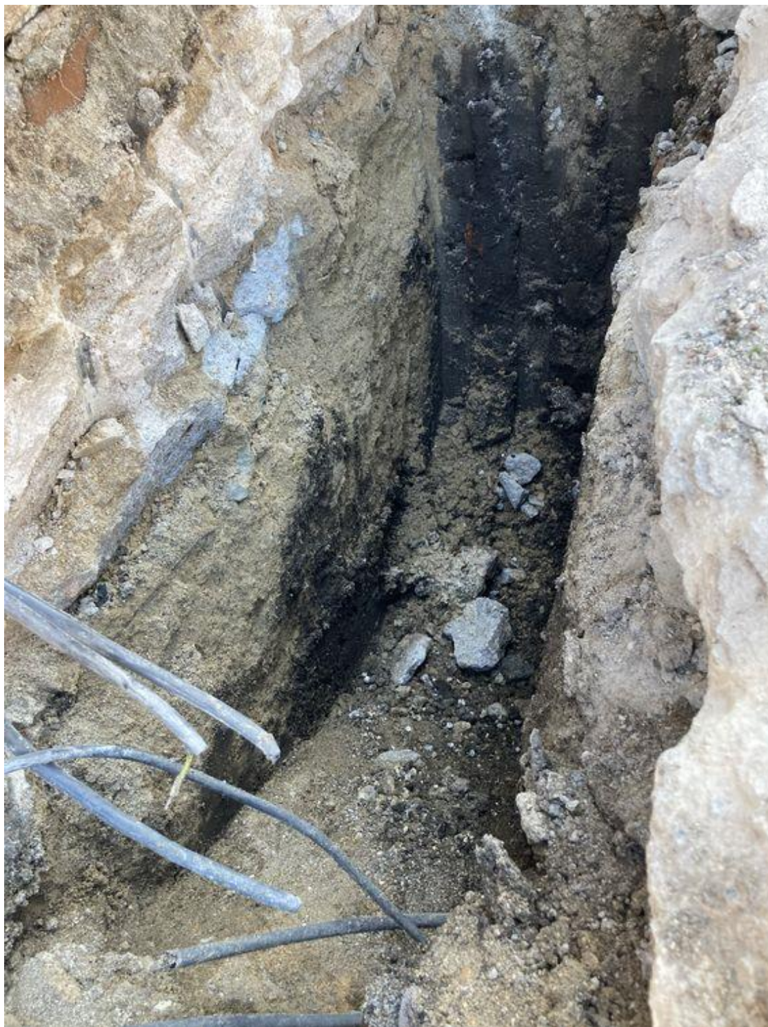
Obr.3. Zemní kopaná sonda v místě základů
