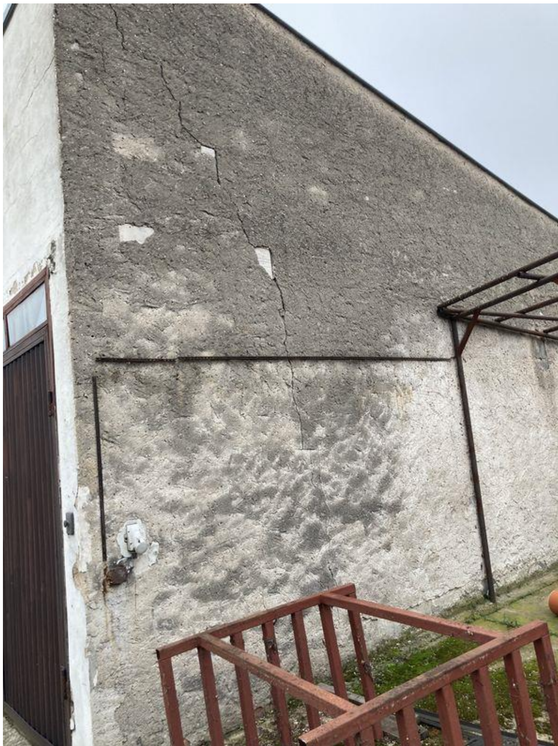
Obr.2. Trhliny ve štítové stěně garáží.
